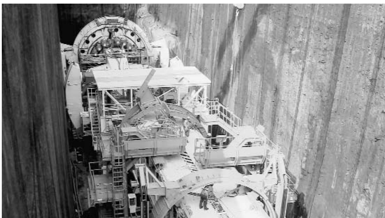
Die Wagner Firma Rowa Tunnelling Logistics AG setzt bei ihrer Arbeit gewaltige Maschinen ein. Bild zvg
